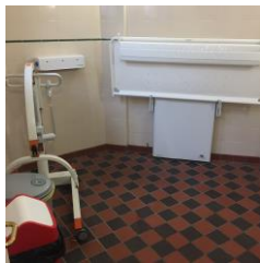
Henblas Street Toilets
